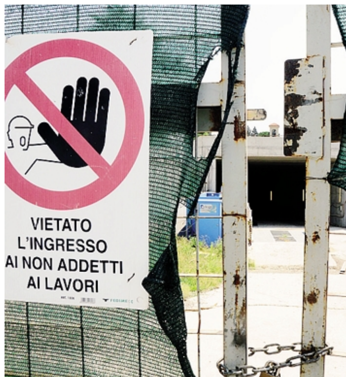
Il cantiere della galleria di Chiuso è fermo
