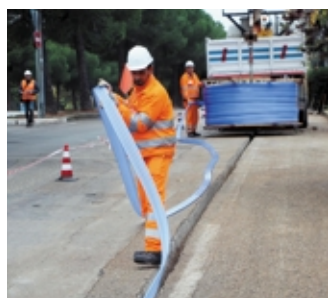
Operai al lavoro per il cablaggio
