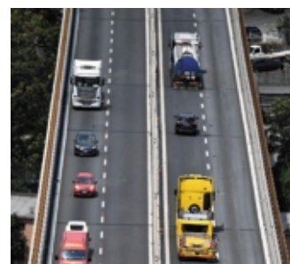
Autostrada di Genova
