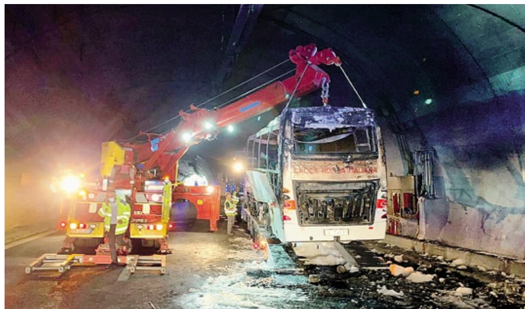
La galleria è stata pesantemente danneggiata dall'incendio dell'autobus
