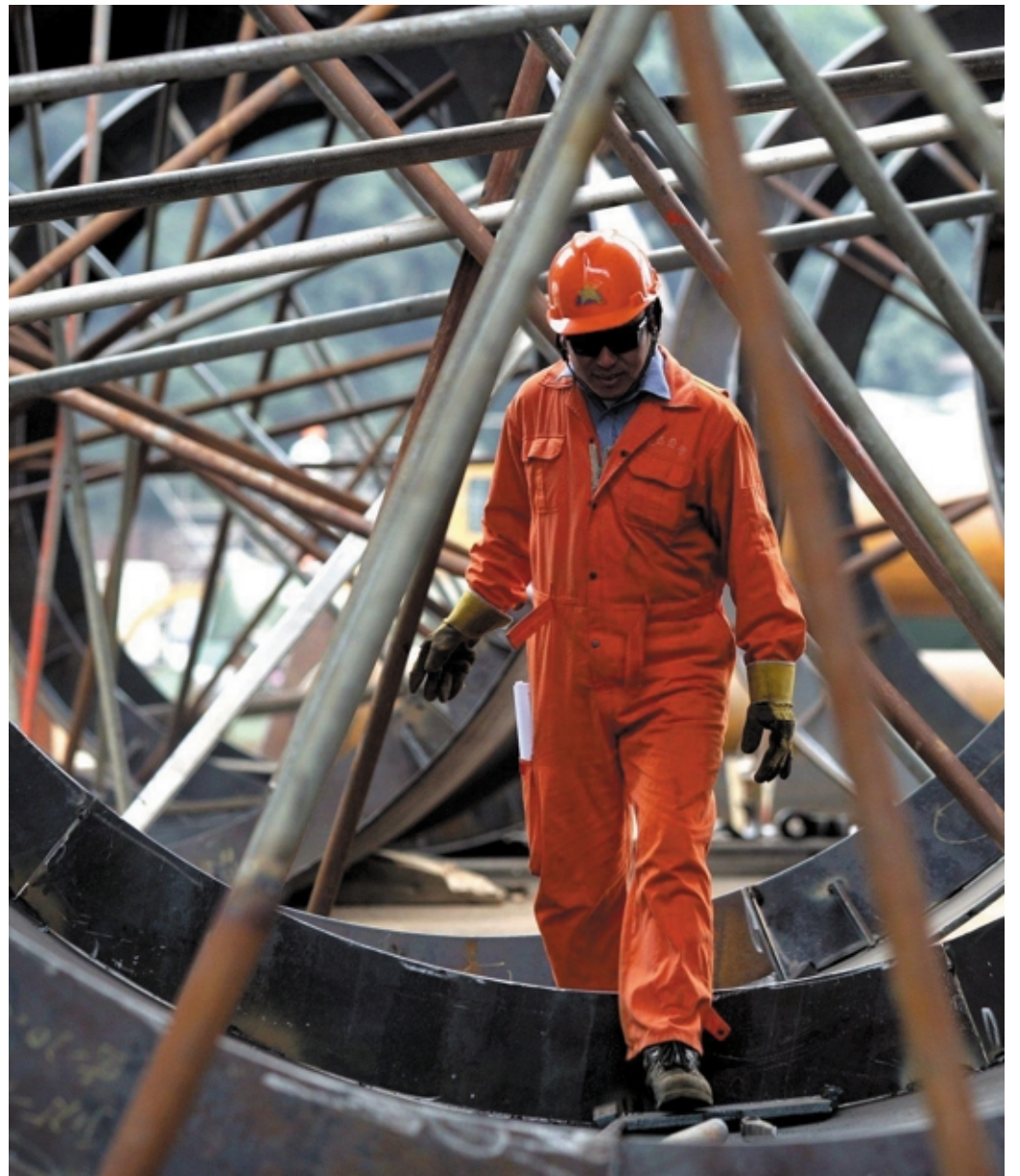
Un operaio al lavoro in un cantiere industriale ANSA
