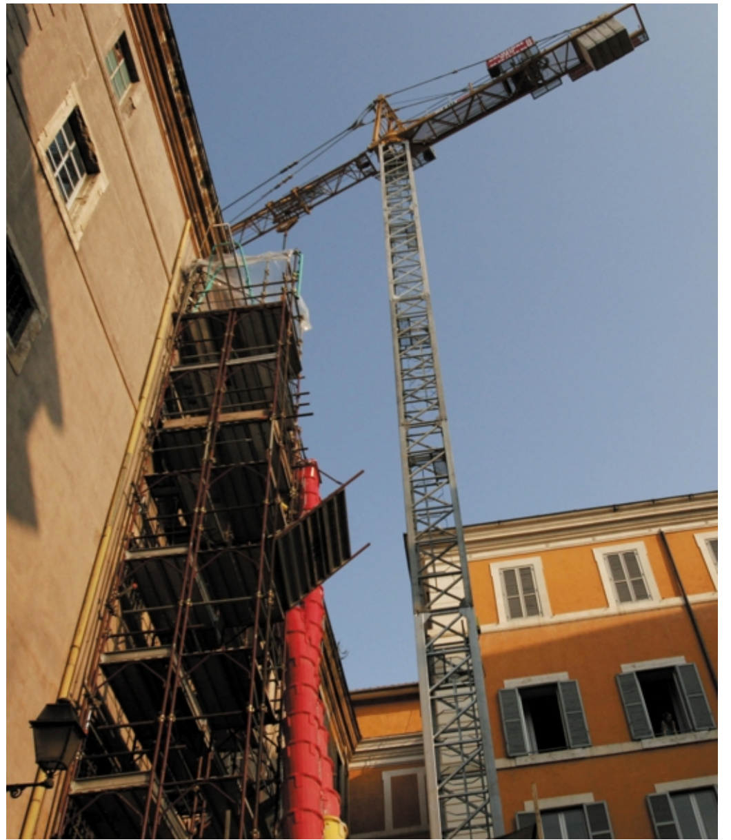
La facciata esterna di un edificio in ristrutturazione ANSA
