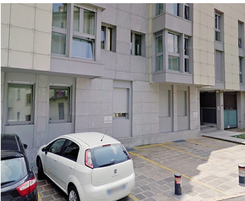
L'ingresso di Confindustria Lecco e Sondrio in via Caprera a Lecco
