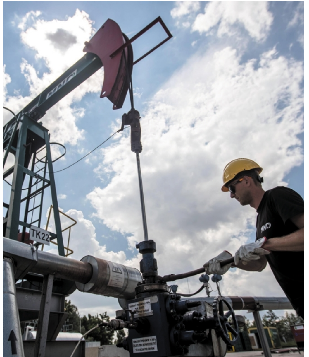
Un operai all'interno di un impianto di estrazione per il petrolio
