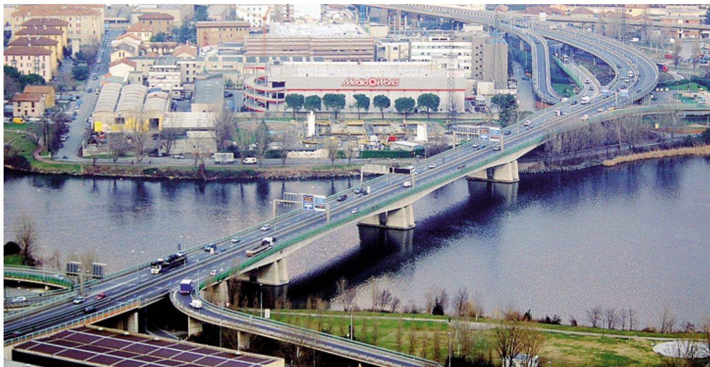
Il nuovo manufatto andrebbe ad affiancarsi al Terzo ponte: il numero di corsie dipende dalle scelte politiche e dai finanziamenti in gioco
