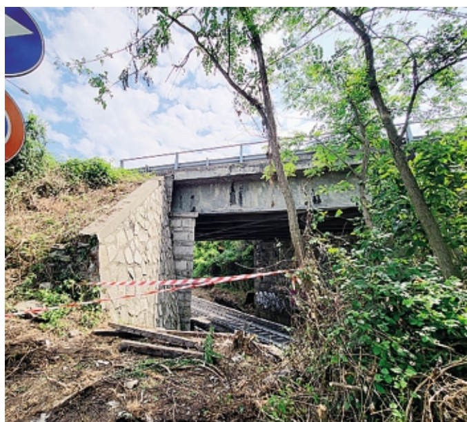
Il ponte sulla provinciale 51 sarà rifatto: nuova soletta
