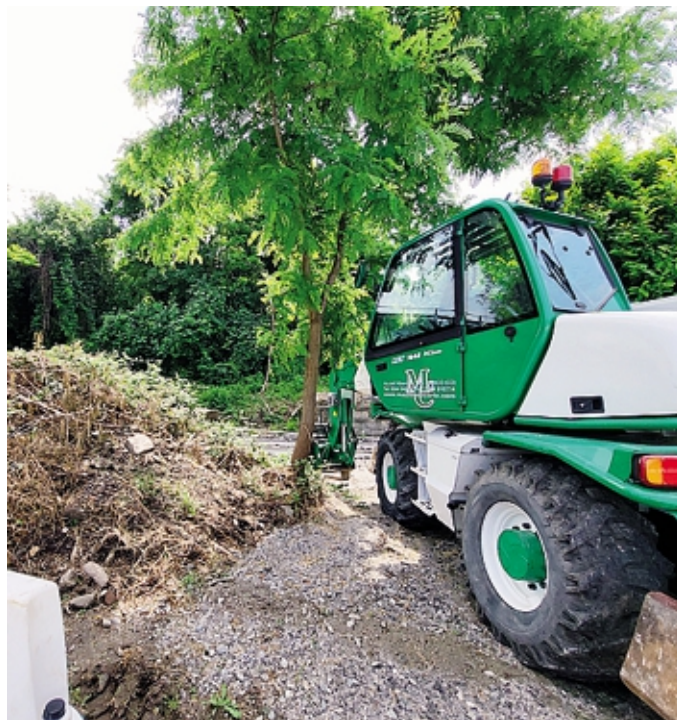
Mezzi pesanti già al lavoro per la rimozione del verde
