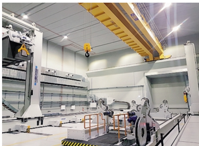
Un particolare della Heppenstall Europe-Lario Impianti a Olginate
