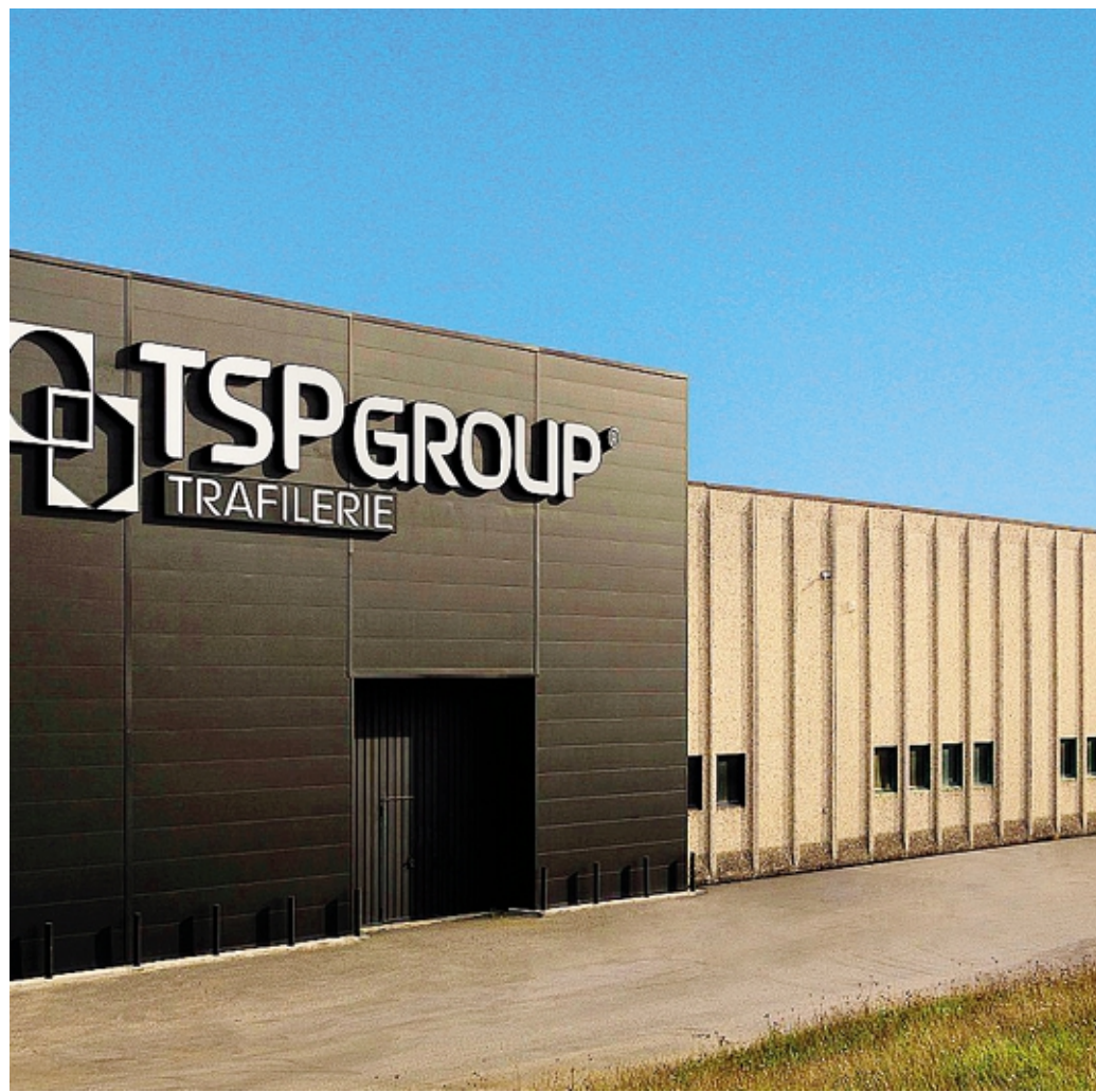
La facciata dello stabilimento di Molteno delle Trafilerie San Paolo
