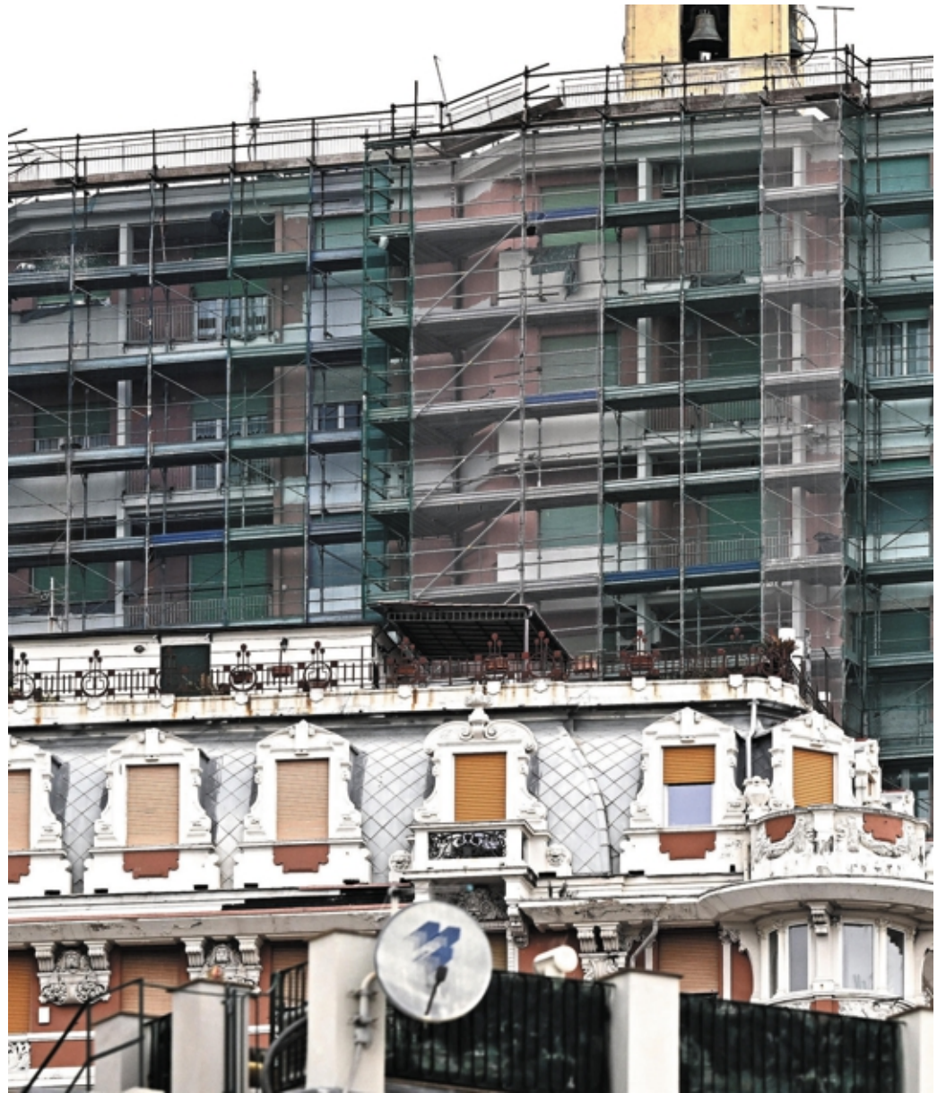
Ponteggi per lavori sulle facciate in città a Genova ANSA
