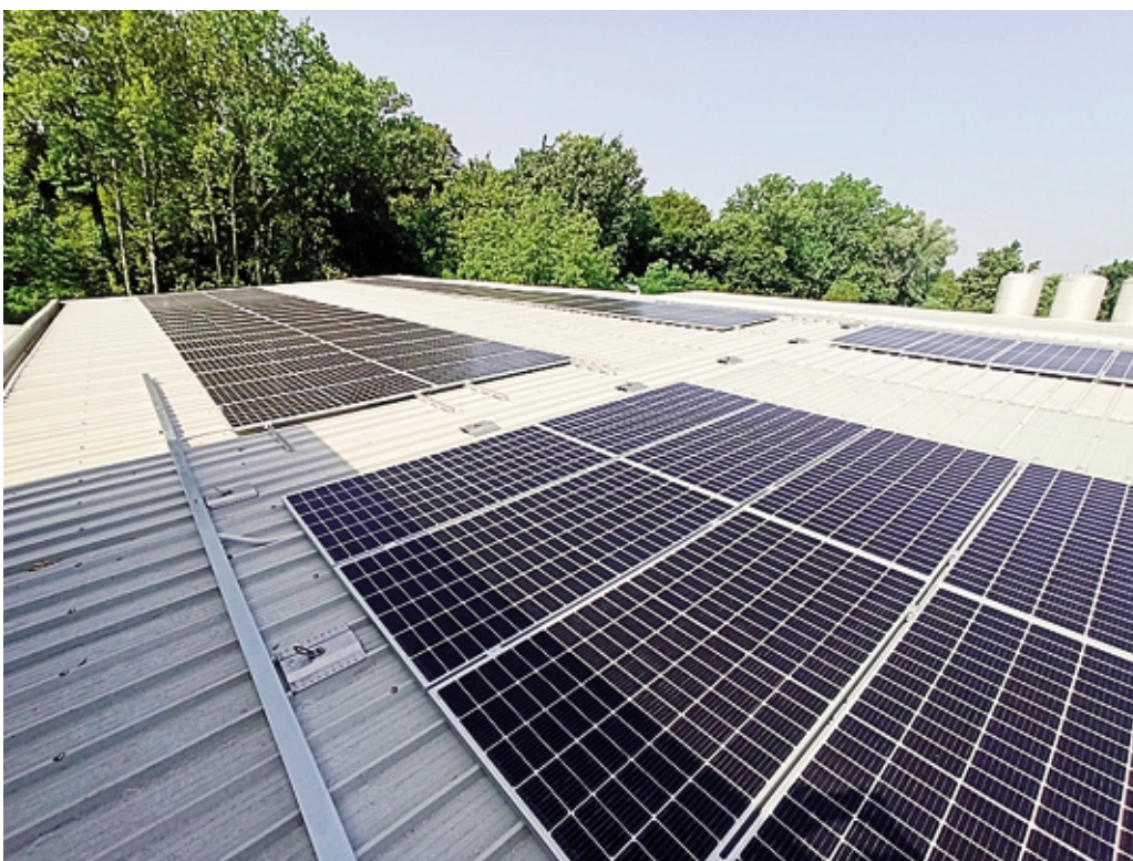
Per Metalfold, l'installazione di un impianto fotovoltaico sulla copertura della nuova sede di Garbagnate
