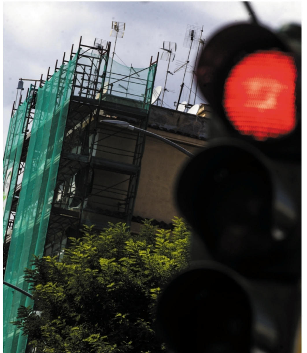
Un'impalcatura per i lavori di ristrutturazione di un condominio ANSA
